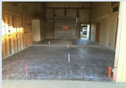
Inside concrete pour
