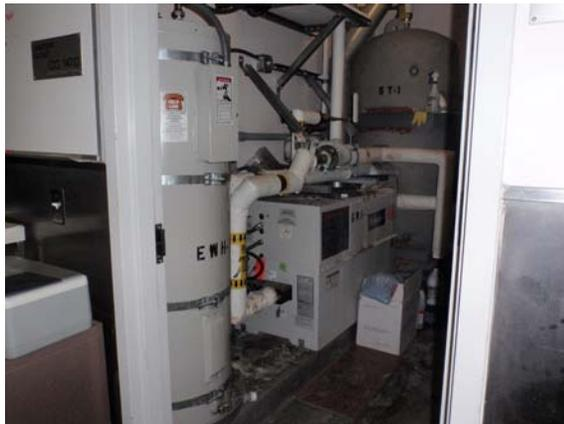
FIGURE 8 ENERGY STAR HEAT PUMP DHW HEATER
